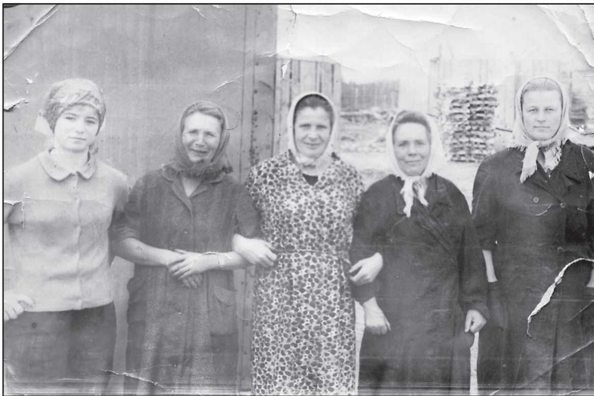
Подсобные рабочие на стройке, с. Гари, 1965 год.
